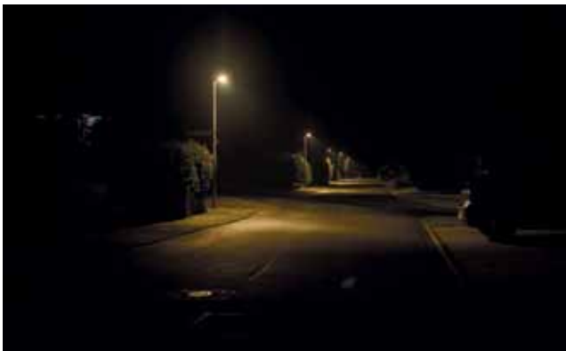
Straßenzug mit abgeschirmter Beleuchtung
