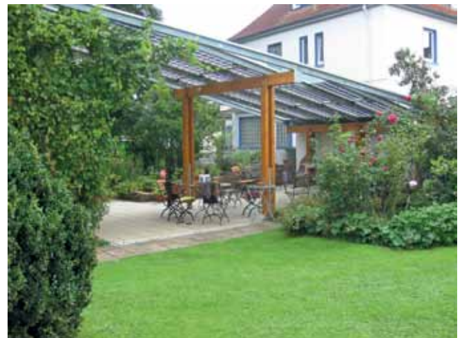
Smarte Kombination aus Energiegewinnung und Schutzdach
