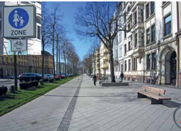
Goethestraße in Kassel. Insgesamt eine gelungene Umgestaltung des Straßenraums, doch der Radverkehr kam zu kurz: Trotz großer Flächenverfügbarkeit wurde der breite Boulevard als Fußgängerzone eingestuft, ungeachtet der Tatsache, dass hier eine der wichtigsten städtischen Radrouten verläuft.
