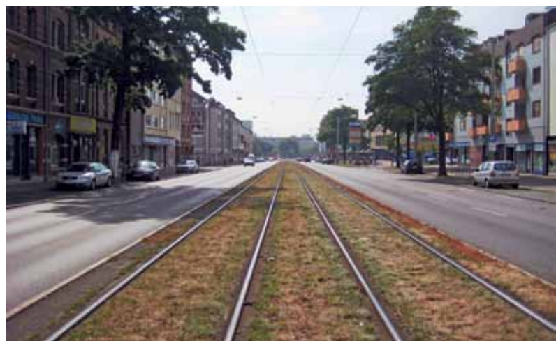
Holländische Straße in Kassel. Ein Straßenraum, der nur mit dem Fokus auf die Anforderungen des fließenden Verkehrs gestaltet wurde. Aufenthaltsfunktionen oder Fußgängerquerungsmöglichkeiten blieben so gut wie unberücksichtigt. Der seit langem währende Niedergang des Einzelhandels in dieser Straße belegt diesen Missstand.
