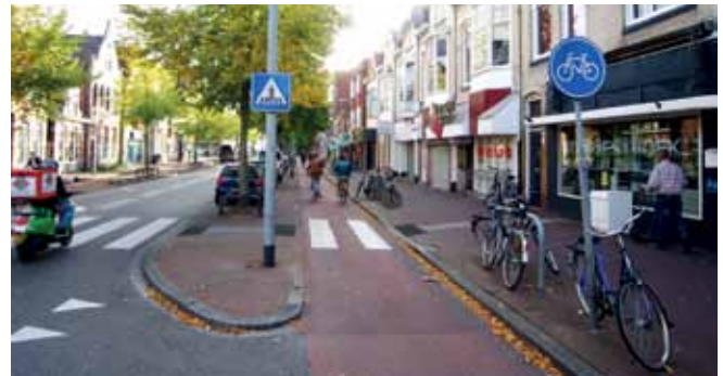
Niederländisches Prinzip eines Einrichtungsradschwerges zwischen Gehweg und Längsparkstreifen. Im Gegensatz zum deutschen Gehwegradweg befindet sich der Radstreifen auf Fahrhahnniveau. Durch diese Trennung werden Konflikte zwischen Fuß- und Radverkehr minimiert. Im Bild auch gut zu sehen ist der Abstandsstreifen zwischen Radstreifen und parkenden Autos, um das „Autotürenproblem“ zu umgehen.
