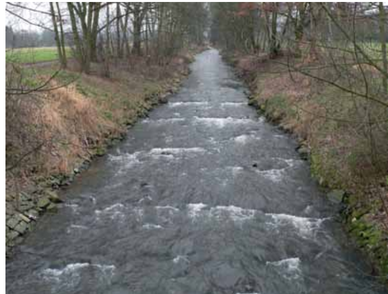
Der Weg direkt an der Gewässeroberkante der Losse in Bettenhausen verhindert mit der noch vorhandenen Uferbefestigung, mehr Raum für eine natürliche Gewässerdynamik zuzulassen
